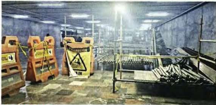
ENTRE MATERIAL. Pasajeros deben pasar entre varillas y pisos en restauración para llegar a los andenes de la estación General Anaya.
