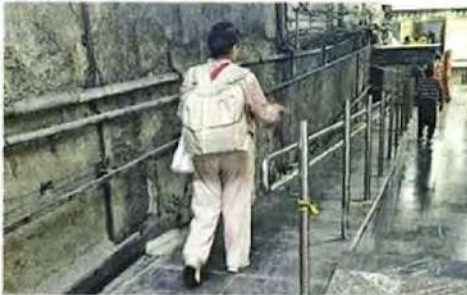
Las paredes lucen sin recubrimiento mientras se realiza su restauración.
