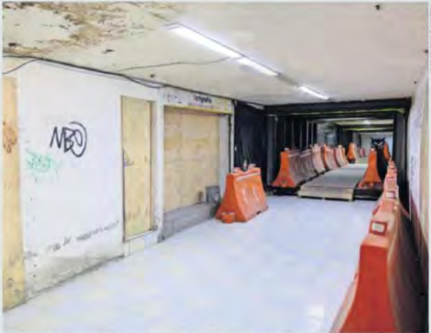
Actualmente 13 pasos a desnivel ubicados sobre Calzada de Tlalpan son rehabilitados como parte de las obras que se realizan por el Mundial de Fútbol. Los locatarios fueron reubicados temporalmente en otras plazas comerciales.
