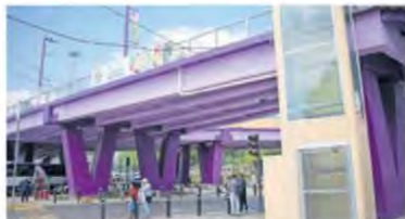
Los elevadores que habían quedado pendientes, ya están listos para su operación y están destinados a personas con alguna discapacidad.
