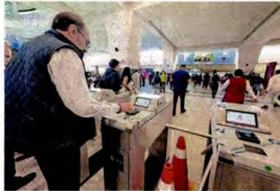
La instalación de los nuevos equipos son parte del sistema de modernización para la ampliación del tren hacia el AIFA.
