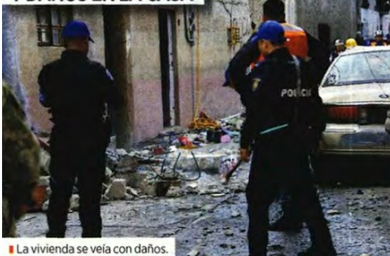
■ La vivienda se veía con daños.
