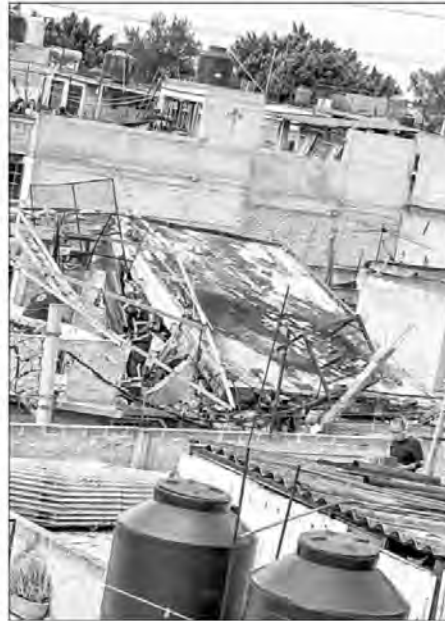
La acumulación de gas en una vivienda de la colonia Carlos Zapata Vela, alcaldía Iztacalco, provocó el colapso de una losa, quemaduras a
