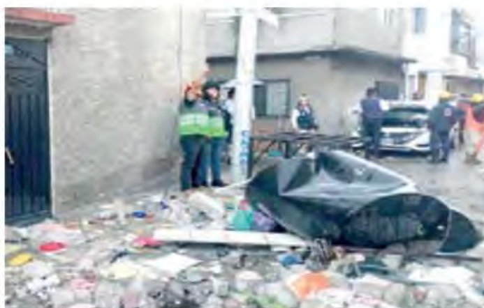
El estallido provocó el colapso de una losa de 20 metros cuadrados. Especial
