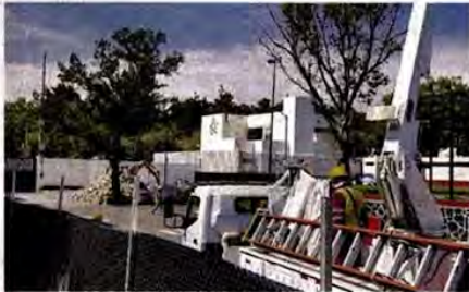
■ Maquinaria y personal ingresó al parque, de acuerdo con imágenes captadas por los vecinos.
