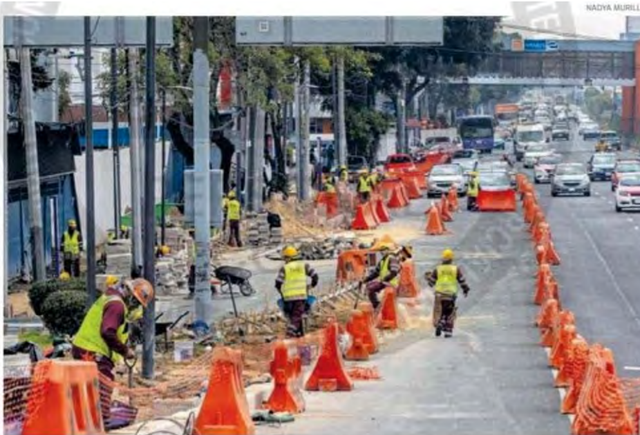
El carril donde se construye la ciclovia sobre calzada de Tlalpan ya está cerrado a la circulación de ciclistas
