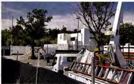
■ Maquinaria y personal ingresó al parque, de acuerdo con imágenes captadas por los vecinos.
