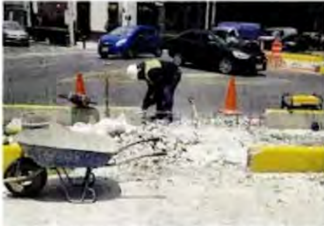
■ Con palas, trabajadores recogían el cascajo de los muretes y los colocaban en carretillas.
