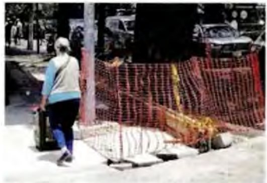
■ Peatones deben esquivar las obras que siguen pendientes y que están delimitadas con malla ciclónica.
