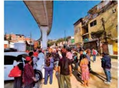
Exigen atención a los daños ocasionados a sus viviendas
