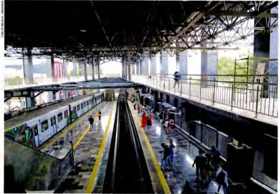
Los trabajos se concentran en las rampas que darán acceso del Metro Chabacano al Jardín Flotante, según trabajadores.
