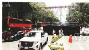
En Reforma, ayer se instalaban las estructuras de las pantallas en las que se proyectará el partido.
