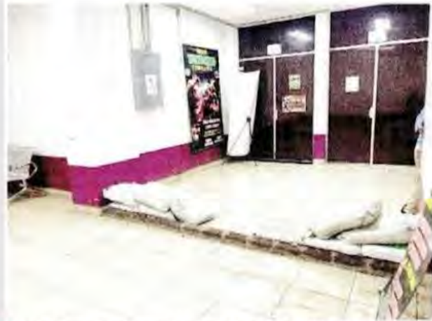
Pese a los costales y una pequeña barda de ladrillos, el agua ingresó el jueves a las instalaciones de lugar.
