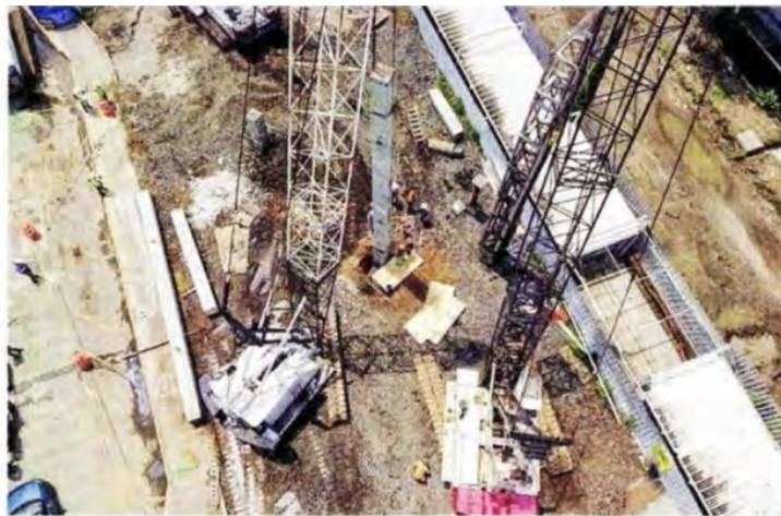
■ Así lucen las obras del ramal en las inmediaciones de la estación Tláhuac del Metro
