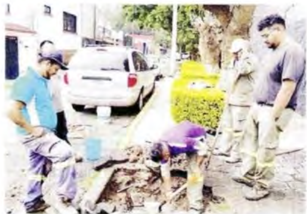
Trabajadores aún llevan a cabo obras en banquetas de San Jerónimo Lídice.
