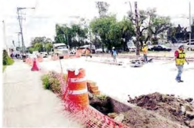
En los carriles laterales, a la altura de la estación Peñón Viejo, aún se realizan obras hidráulicas.
