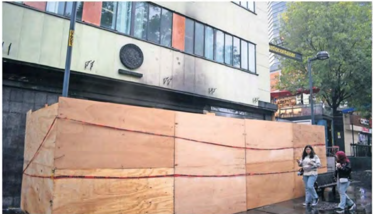
En el inmueble ubicado sobre avenida Juárez se colocaron tableros de madera y se acordonó la zona.
