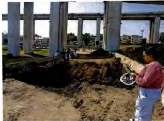
Se procederá a construir una caja disipadora para contener y mantener la estabilidad del terreno donde se encontraba la grieta: Segiagua.
