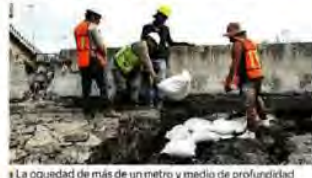
La oquedad de más de un metro y medio de profundidad fue sellada con grava y tepetate.
