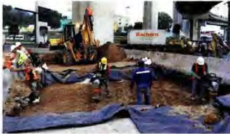
Personal de Segiagua supervisa los labores de relleno de la grieta en el bajo-punto.
