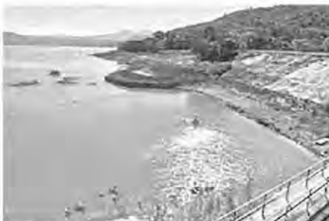
Para evitar los desbordes, realizan desfogues de agua
