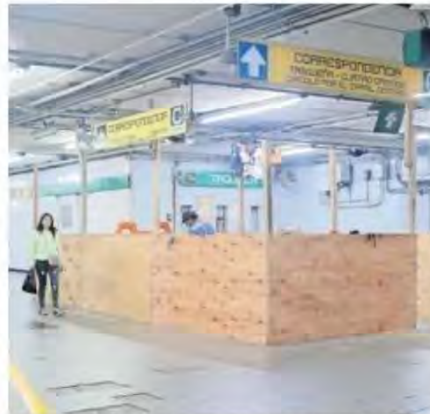
Este martes, trabajadores colocaban piso en la zona de transbordo de la Línea 8 a la L2.
