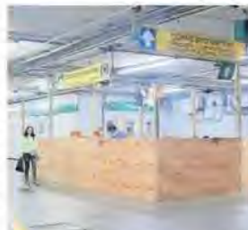
Este martes, trabajadores colocaban piso en la zona de transbordo de la Línea 6 a la 12.
