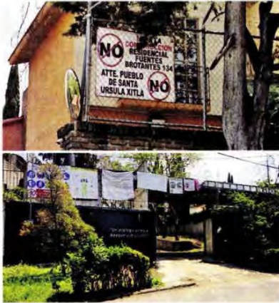
Vecinos se oponen a la obra y afirmaron que tenía irregularidades.
