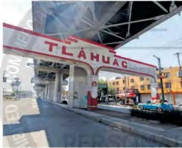
Estructura refozada en las columnas del tramo Olivos y Tezonco
