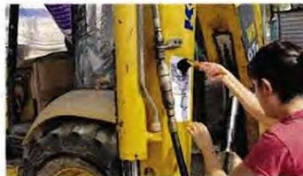
Durante la movilización, intervinieron maquinarias con las que se llevan a cabo la remodelación del Estadio.
