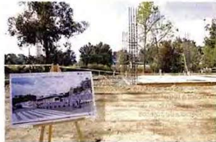
■ Las obras de la Clínica Condesa en la GAM iniciaron ayer. Se prevé que se inaugure en febrero del próximo año.
