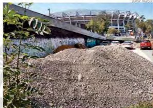
Rehabilitan la infraestructura peatonal que va desde calzada de Tlalpan, hasta Avenida del Imán.
