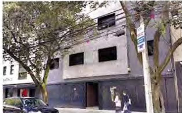
El inmueble cuenta con al menos tres pisos, en los cuales se busca habilitar oficinas y consultorios.
