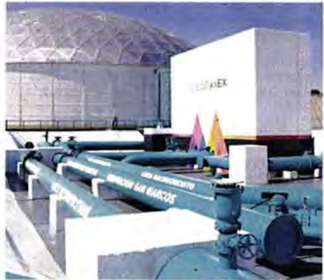
La obra fue entregada dos años atrás, sin embargo, hasta el momento no ha entrado en operación.
