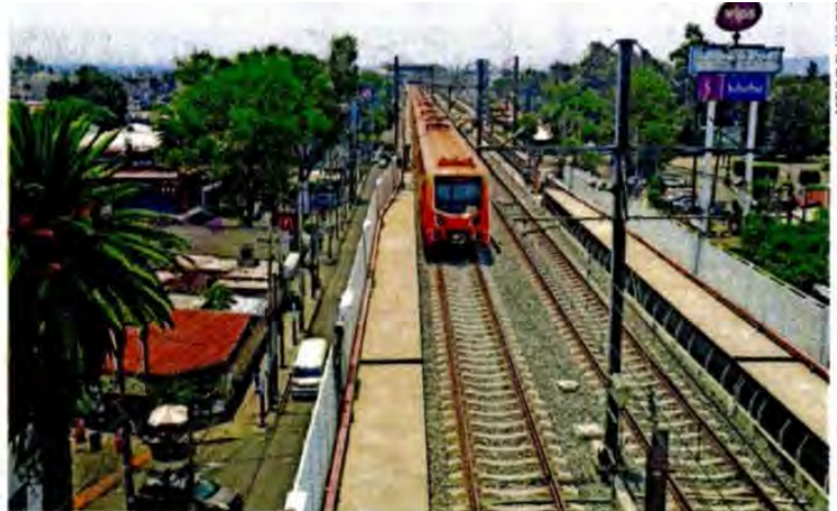
En la Línea Dorada se revisará la estructura del tramo elevado y además se instalará equipo especializado de monitoreo.
