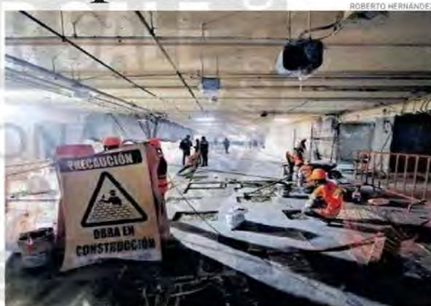
Trabajadores quitan el piso en una estación del Metro capitalino
