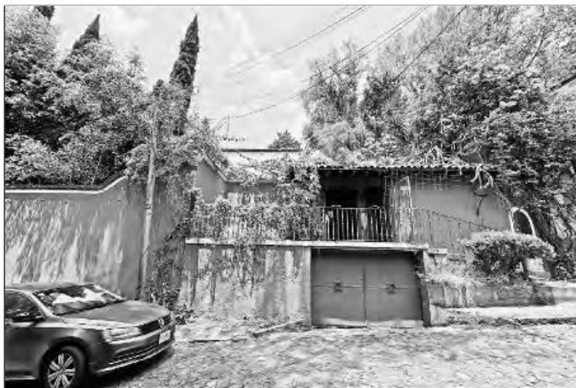
▲ Los dueños del inmueble fueron sacados a la fuerza con ayuda de la fuerza pública capitalina. Foto Yazmín Ortega
