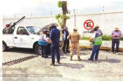
También abrieron zanjas en diversos puntos de Añil para indagar la presencia de más derrames.
