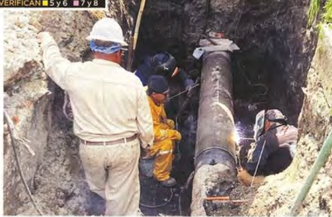
Equipos especializados repararon la tubería en la que detectaron el desperdicio.
