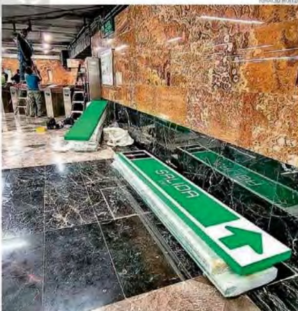
El mantenimiento y remodelación dentro de las instalaciones del Metro se concentran en las obras del Mundial del Fútbol en las Líneas 2, 3 y 7
