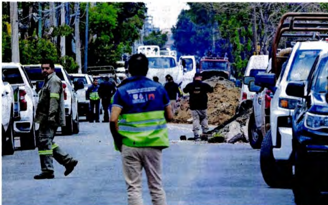
La Secretaría de Gestión Integral de Riesgos y Protección Civil realizó trabajos de mantenimiento y limpieza en la red de alcantarillado de la calle Añil en la colonia Granjas México de la alcaldía Iztacalco.
