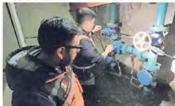
Trabajadores del Metro laboraron, con el agua en los pies, para solucionar el problema de la inundación en vías.
