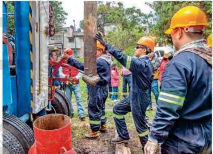
Infiltrarán agua de lluvia a los mantos acuíferos; también se realizarán trabajos de desazolve en presas
