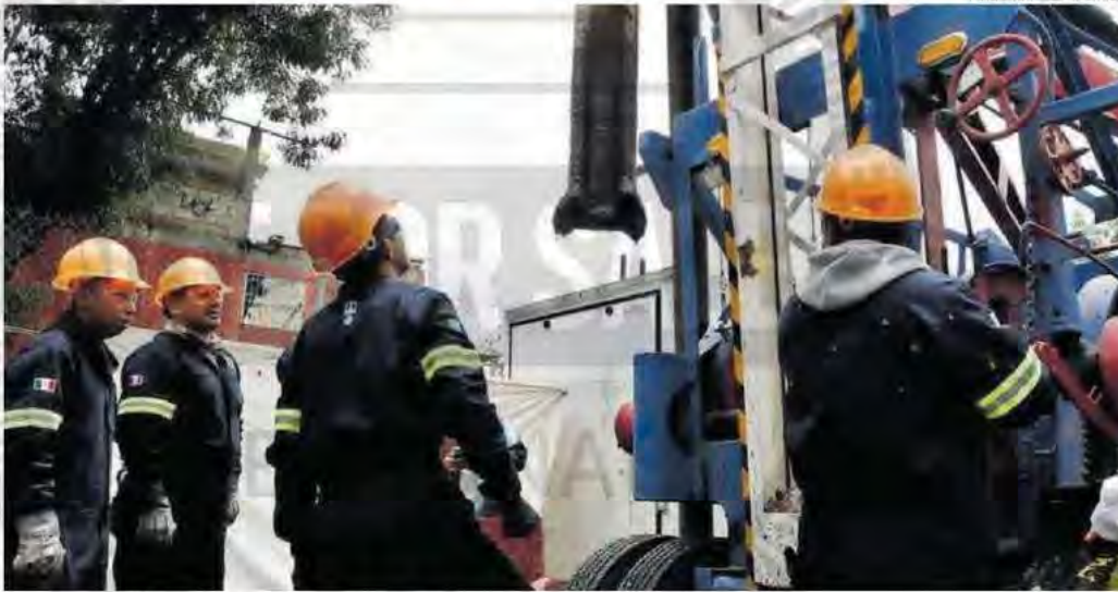
Banderazo de inicio de las obras de los captadores de lluvia pluvial para recargar el manto freático.
