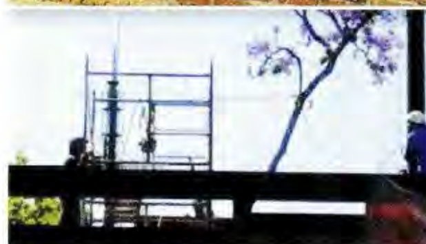
■ Aunque los tapiales lucen sellos de clausura, autoridades constataron que las obras continuaron.
