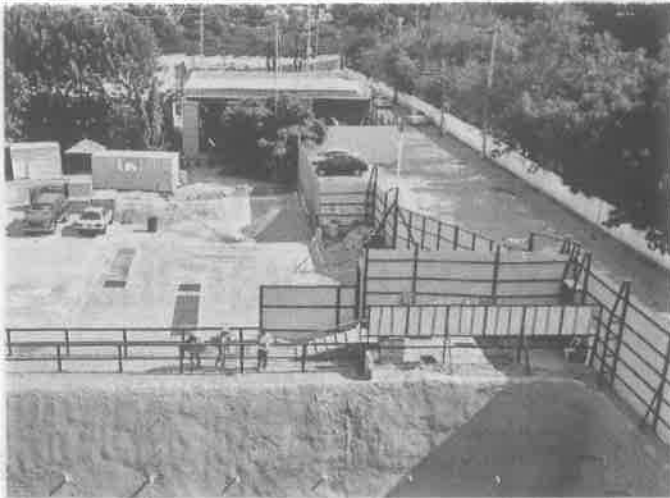
El proyecto registra ya avances en el lugar donde se ubicaba el Colegio Grimm, junto a la autopista México-Toluca.
