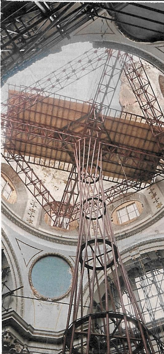
APOYO. Una estructura fue introducida por el mismo orificio de la cúpula para servir como andamio.
