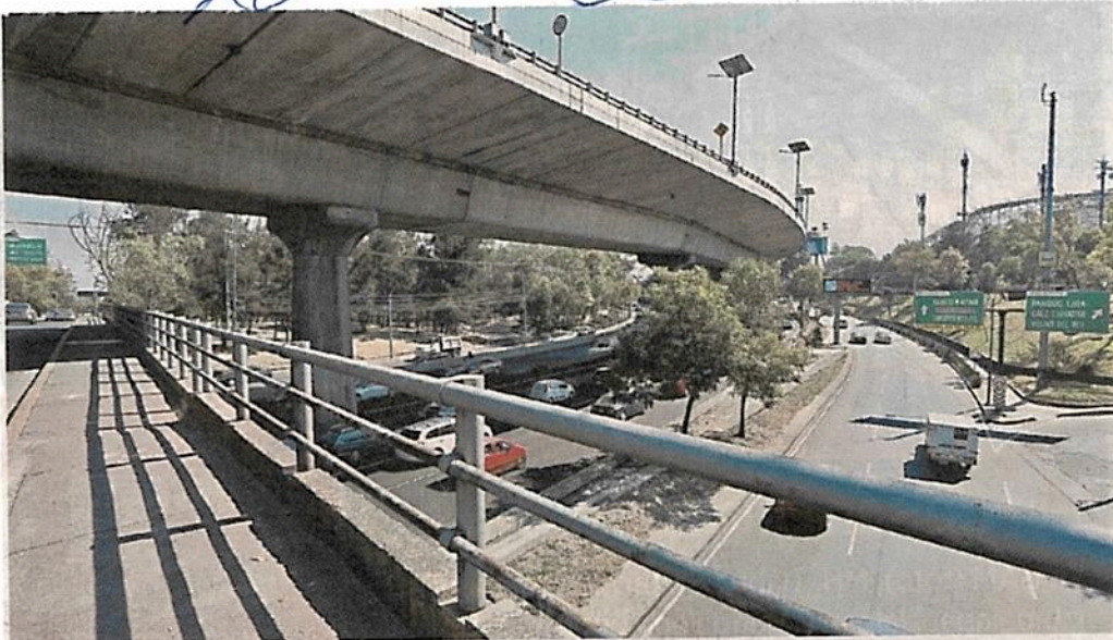
Se prevé que el puente pase sobre Periférico y bajo la Autopista Urbana Norte.
