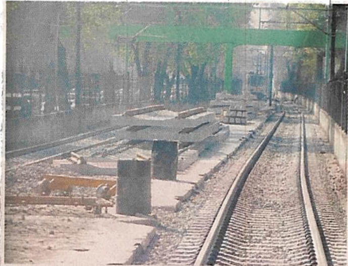
ayer trabajadores realizando labores de limpieza en las vías.
