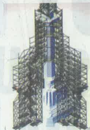
El sistema de andamiaje mide 35 metros de altura.
