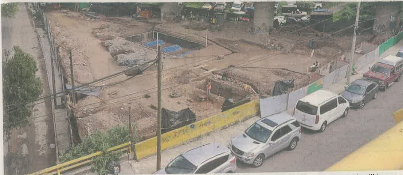
Desde el puente se observa la instalación de tanques y la construcción acelerada de estaciones de carga de combustible.
