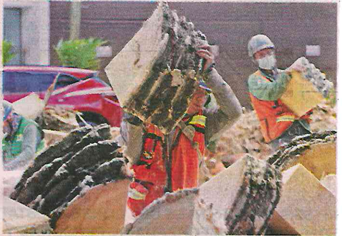
■ Los troncos cortados de las 32 palmeras derribadas son colocados en el camellón.
