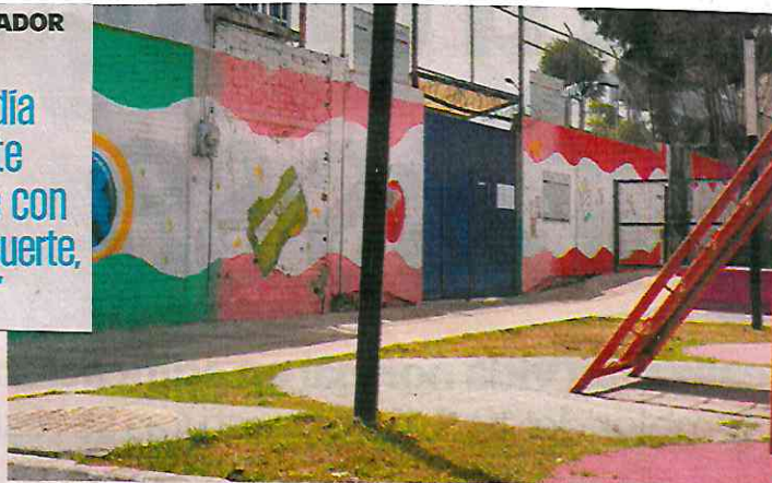
La escuela Albino García , de Santa Cruz Meyehualco, en la alcaldía Iztapalapa, presenta daños, según la Secretaría de Obras y Servicios.
