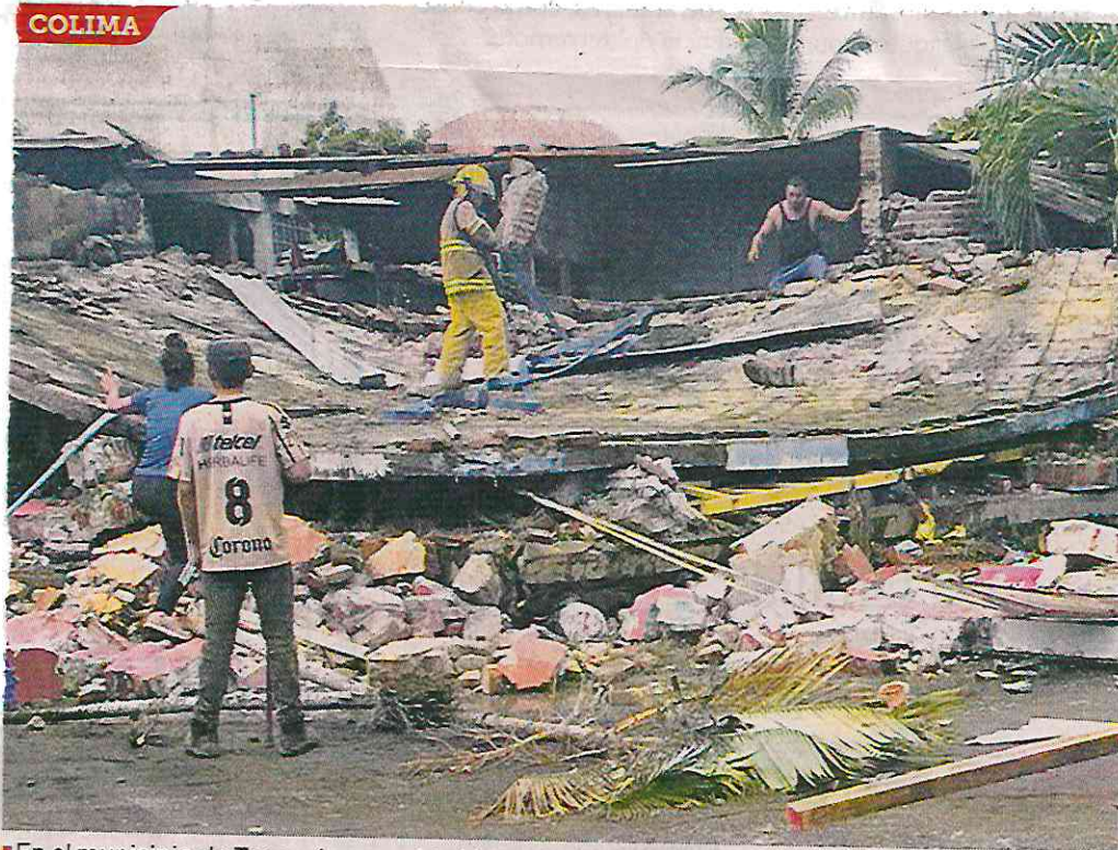
■ En el municipio de Tecomán se registró la explosión de un tanque de gas que derivó en lesiones a tres personas.
