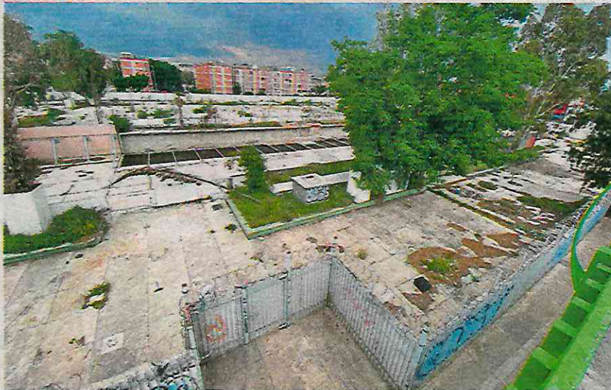
La Clínica 25 del Seguro Social de Iztapalapa tardó dos años en ser demolida
