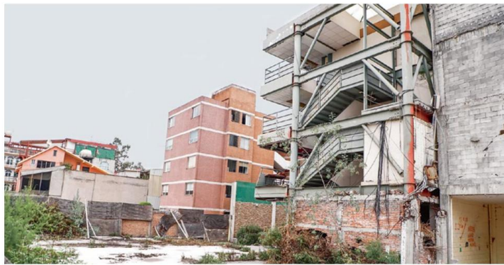
VIGILANCIA. Dentro de las instalaciones del colegio permanece una pequeña guardia de la Policía, que impide que curiosos puedan entrar al plantel.
