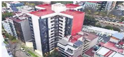
Como Londres 224, 12 mil 710 viviendas dañadas por el sismo del 19-S fueron reconstruidas.
