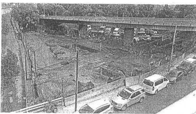
Desde el puente se observa la instalación de tanques y la construcción acelerada de estaciones de carga de combustible.
