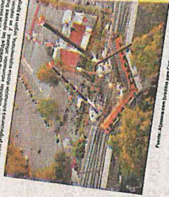
Foto: ESI. Se muestra el colapso del tramo de la Línea 12 de la Noroeste de Metro ESI 84144. El colapso ocurrió el día 24 de octubre de 2018.
