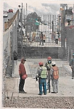
La obra presenta un avance del 70 por ciento.
