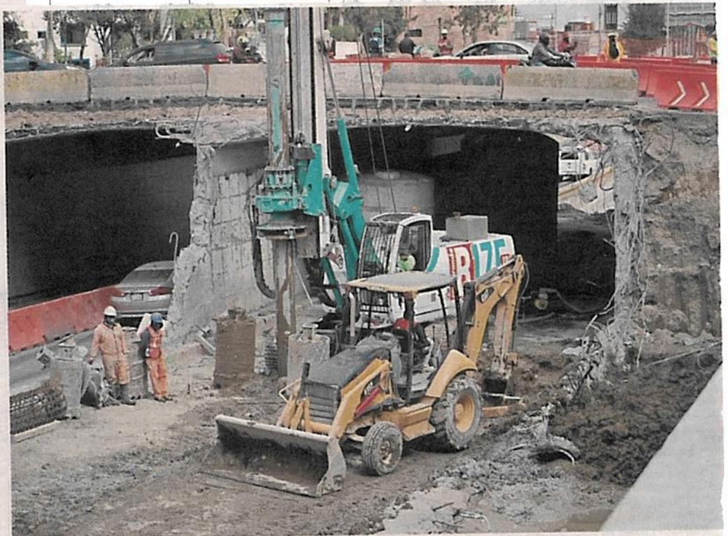
■ Debajo de la unión entre Fray Servando y Francisco Morazán se realiza la ampliación de los túneles para tener 3 carriles por sentido.
