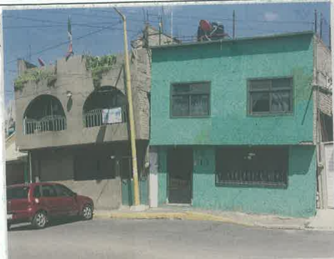
Algunos de los inmuebles tienen hasta 2 grados de inclinación y se encuentran en calles agrietadas.
