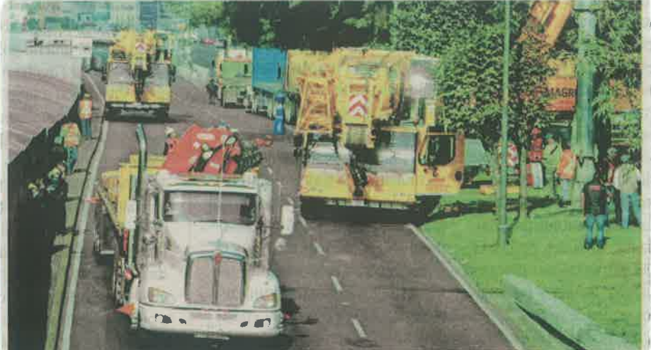
El Viaducto Miguel Alemán debió permanecer cerrado más de 18 horas, con dirección Oriente a Poniente, a la altura de colonia Buenos Aires /FOTO: DAVID DEOLARTE
