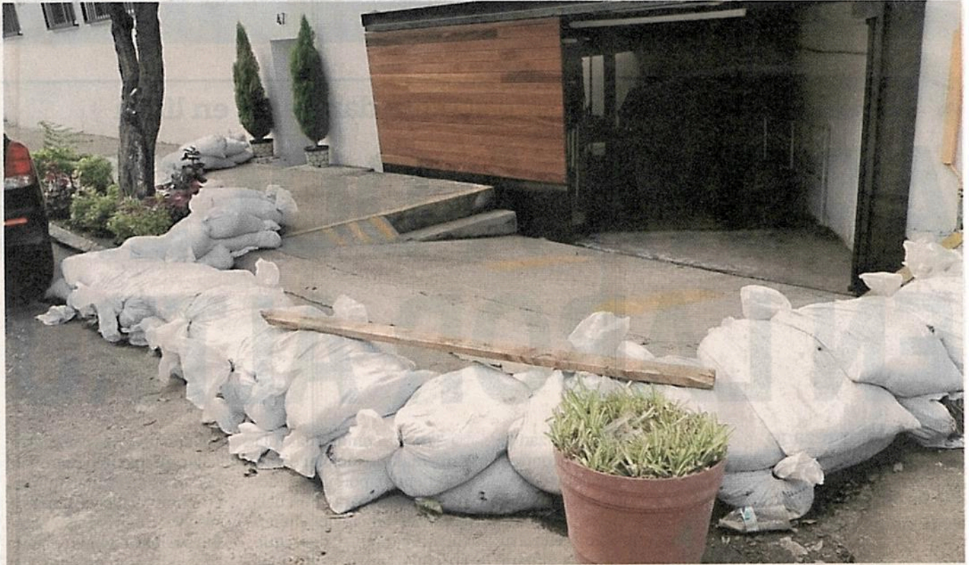
■ Con costaleras de arena buscan evitar que el estacionamiento subterráneo del edificio ubicado en Ajusco 47 se inunde.
