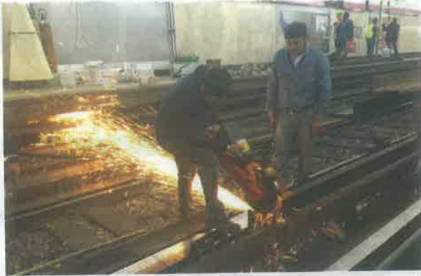
PERSONAL CONTINÚA con los trabajos de reparación en el tramo afectado de la Línea 1 del STC por el incidente, ayer.
