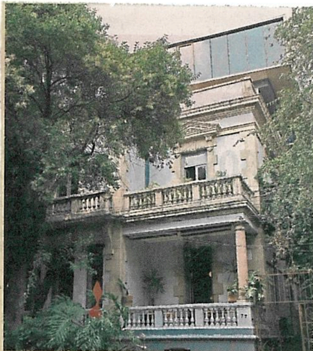
■ Inmueble de Havre 77, dentro del proyecto de regeneración urbana de CDMX.
