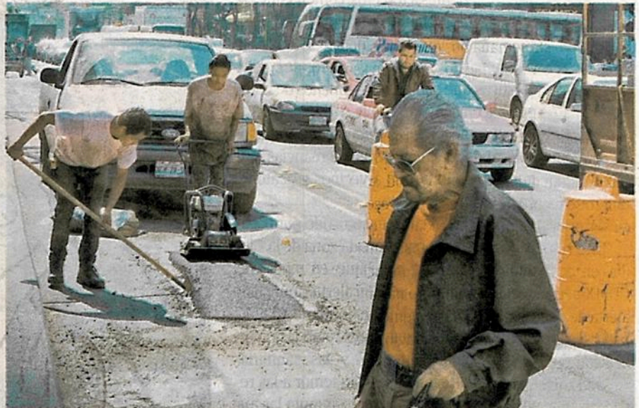
El concreto deberá adecuarse a las condiciones de la tierra donde se colocará /FOTO: SERGIO VÁZQUEZ
