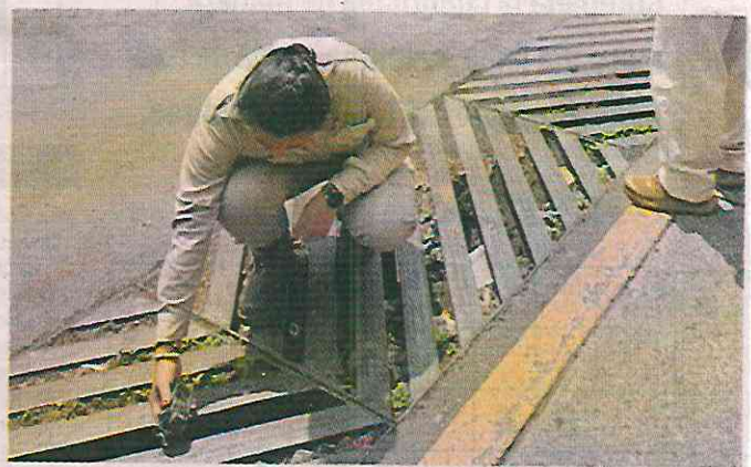
■ Personal de Pemex ingresó medidores a alcantarillas para descartar explosividad, tras constatar un olor a hidrocarburo.
