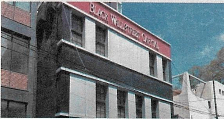
Edificio de Black WallStreet Capita.
