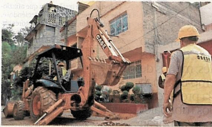
La alcaldesa verificó los trabajos en banquetas y guarniciones.
