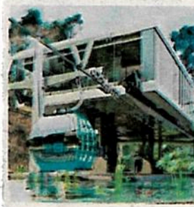
Doppelmayr construirá la Línea 3 del Cablebús
