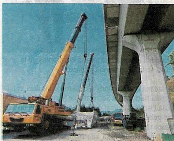
Ya se encuentran montados 12 kilómetros totalmente y solo faltan 5 kilómetros por montar /FOTO GCDMX
