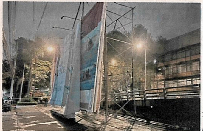
Actualmente se realizan labores para el retiro de espectaculares en azoteas, debido a que están prohibidos.
