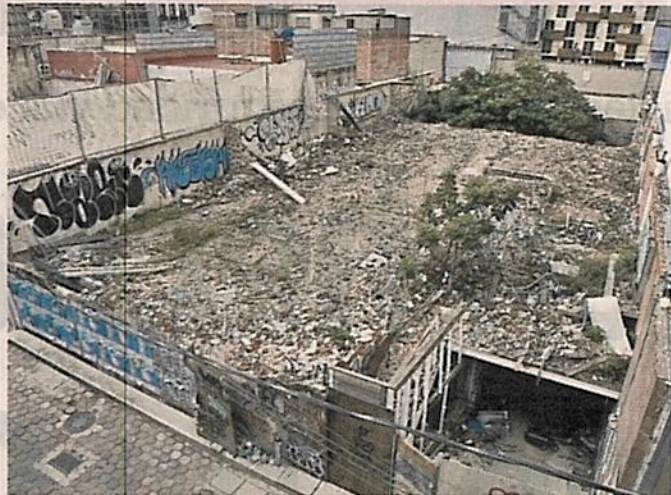
El edificio ubicado en Zapata 56 colapsó en el sismo del 2017.
