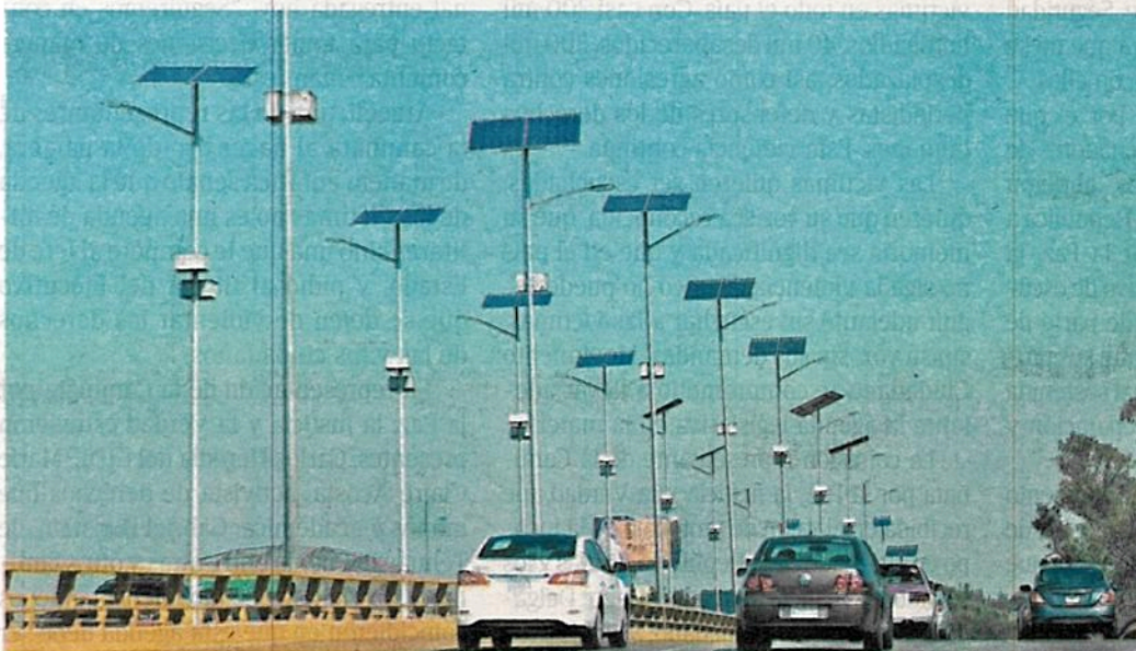
Las nuevas luminarias del Circuito Río Churubusco iluminan de noche la vía, con energía solar captada durante el día /FOTÓ: IGNACIO HUITZIL
