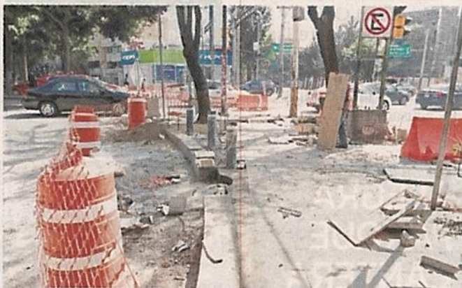
Mientras duran los trabajos se ha confinado un área para seguridad de los transeúntes.
