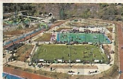
Aspecto general del nuevo espacio parque Cantera para los capitalinos /FOTO: CORTESÍA GCDMX
