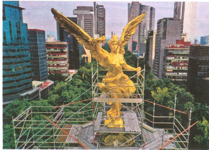
DAÑOS. El Ángel de la Independencia cuenta con 78 placas de acero, de las cuales 16 están deformadas debido a los sismos desde 1957.
