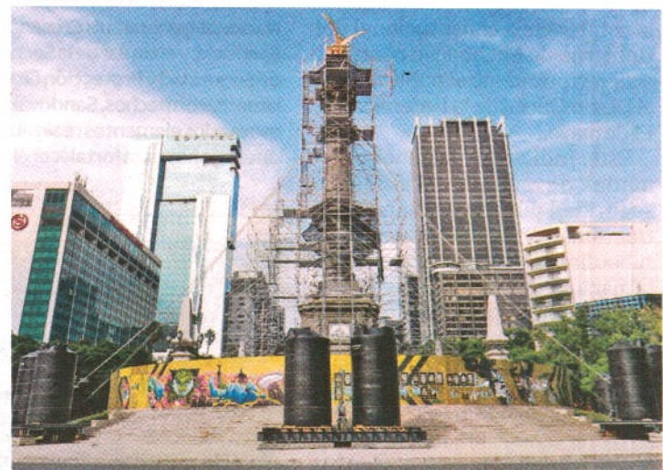
DAÑOS. El Ángel de la Independencia cuenta con 78 placas de acero, de las cuales 16 están deformadas debido a los sismos desde 1957.
