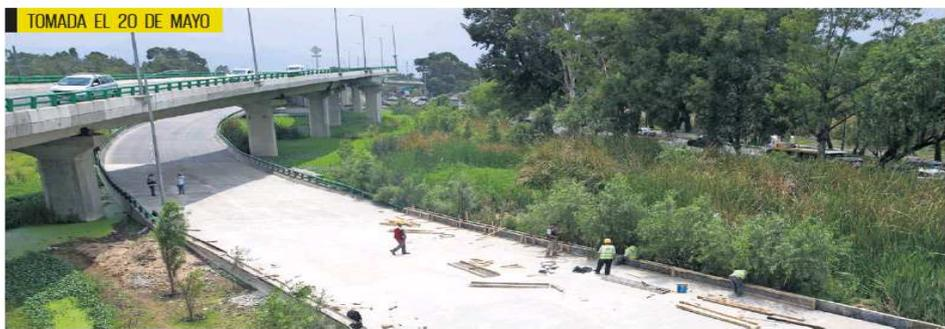
La renovación consistió en cimbrado y colado de guarniciones, relleno fluido y carpeta asfáltica en el cuerpo B del puente.
