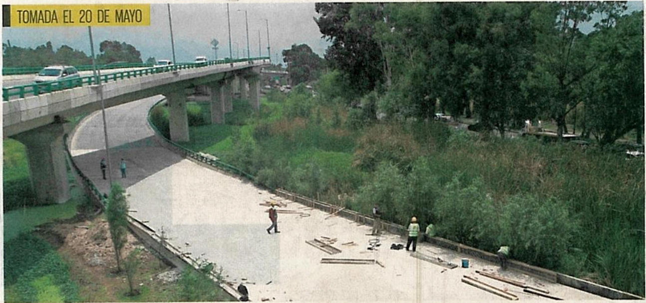
La nivelación consistió en cimbrado y colado de guarniciones, relleno fluido y carpeta asfáltica en el cuerpo B del puente.
