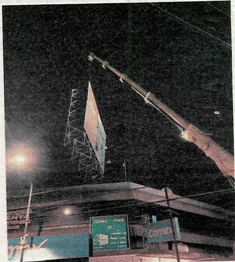
Retiro de publicidad de azoteas.
