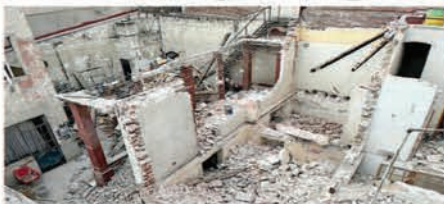
Un inmueble catalogado por su valor patrimonial es objeto de una demolición.
