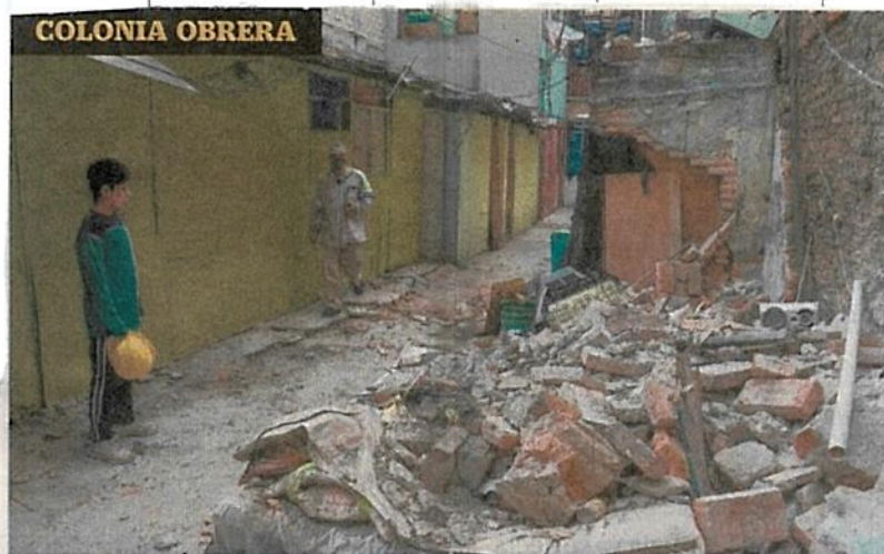
Una vivienda de la colonia Obrera, en la alcaldía Cuauhtémoc, se derrumbó. Sus habitantes, entre ellos un pequeño, lloraban al ver la escena.
