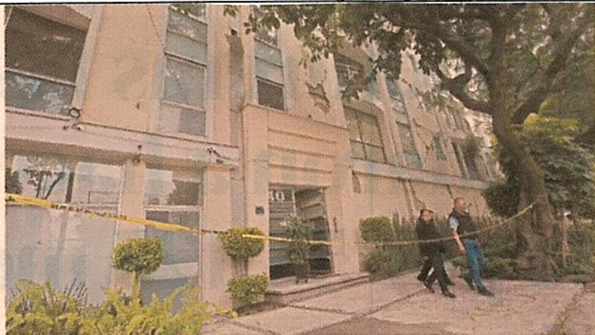
Edificios de casa habitación fueron los principales afectados. FOTO EE: ROSARIO SERVÍN
