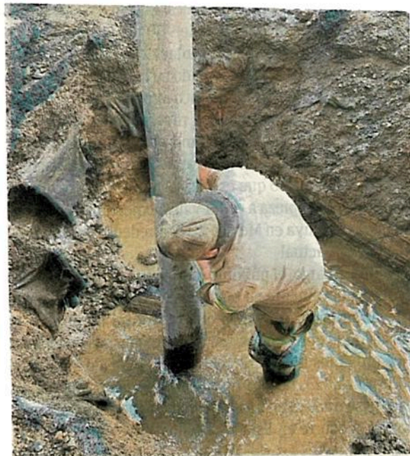
Reparación sin obstruir vialidad ni cerrar la llave a colonias aledañas /CORTESÍA: ALCALDÍA VENUSTIANO CARRANZA
