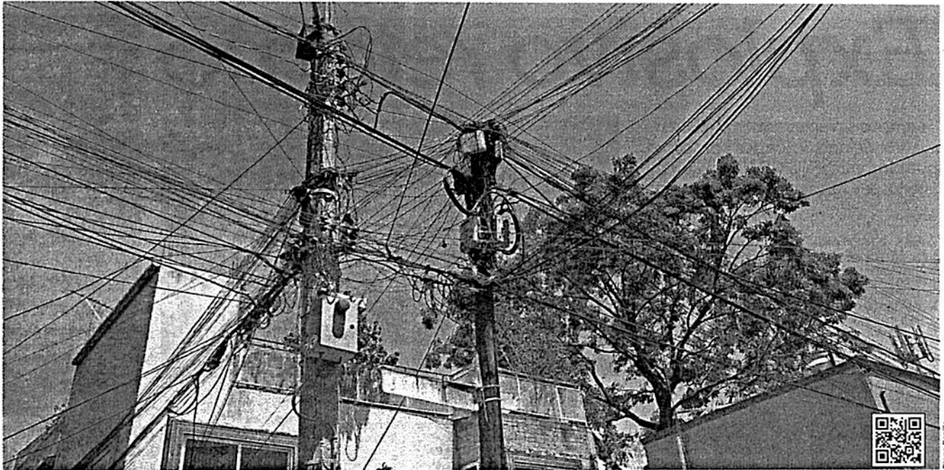
DE PESO. Un poste puede llegar a cargar hasta 100 kilos de cable. Buena parte ya no se utiliza y otro tanto son rollos que dejan las empresas para conexiones futuras.
