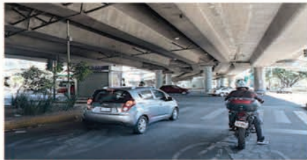
■ Un estudio recomienda incorporar infraestructura verde para mitigar el ruido que se registra en vialidad de la Ciudad.
