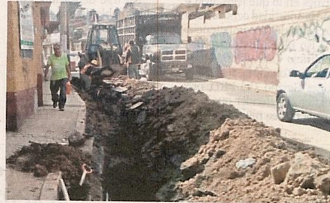
Las obras en la red del suministro de agua tomaron por sorpresa a pobladores de San Bartolo Ameyalco.
