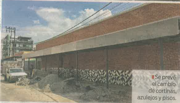
Los locatarios reportaron que trabajos llevan un mes de retraso.
