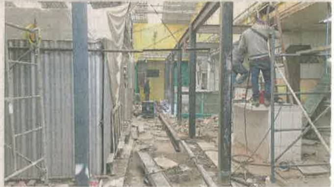
Al interior del inmueble ubicado en Benito Juárez, la mitad se encuentra en remodelación.
